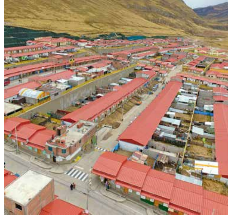
Foto aérea de Nueva Morococha 莫罗科查新城
