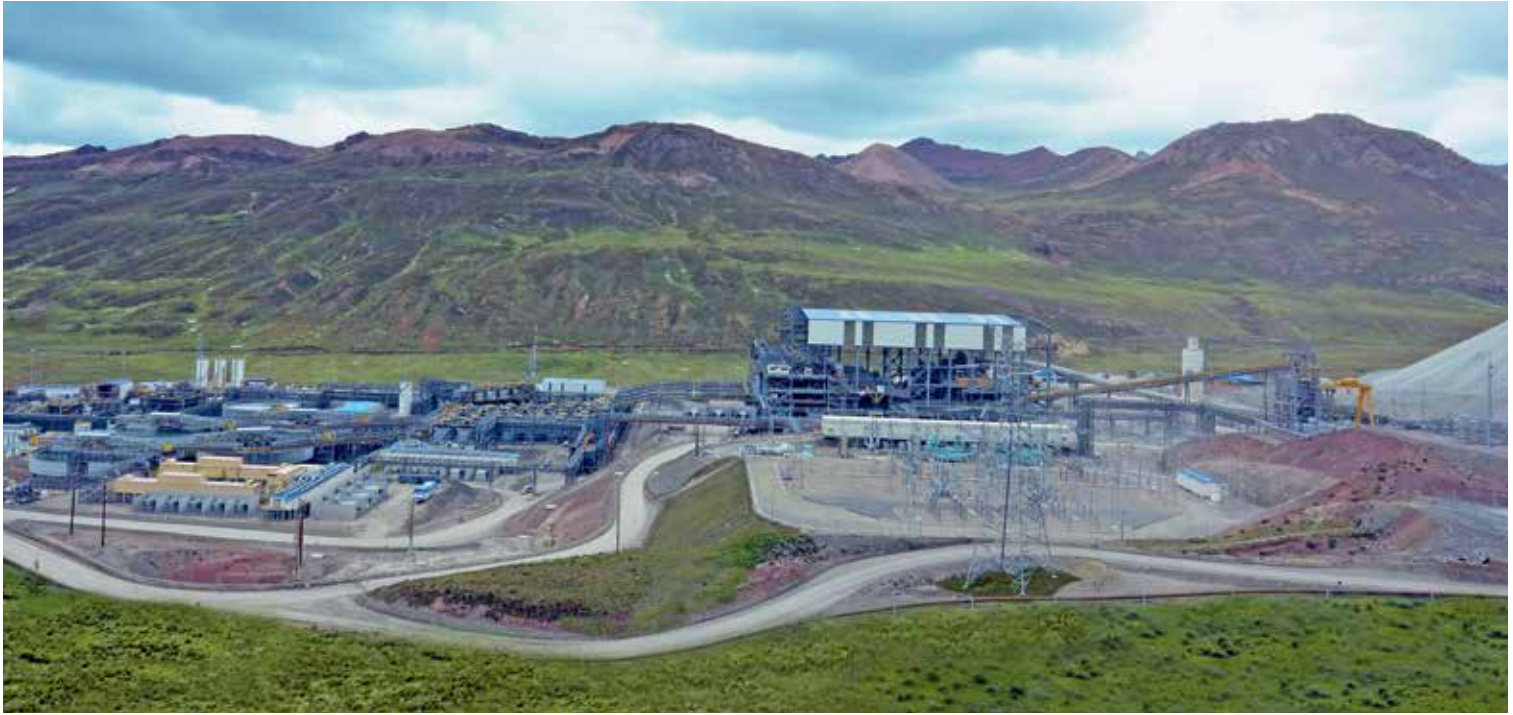
Vista panorámica de la planta concentradora 选厂全景
