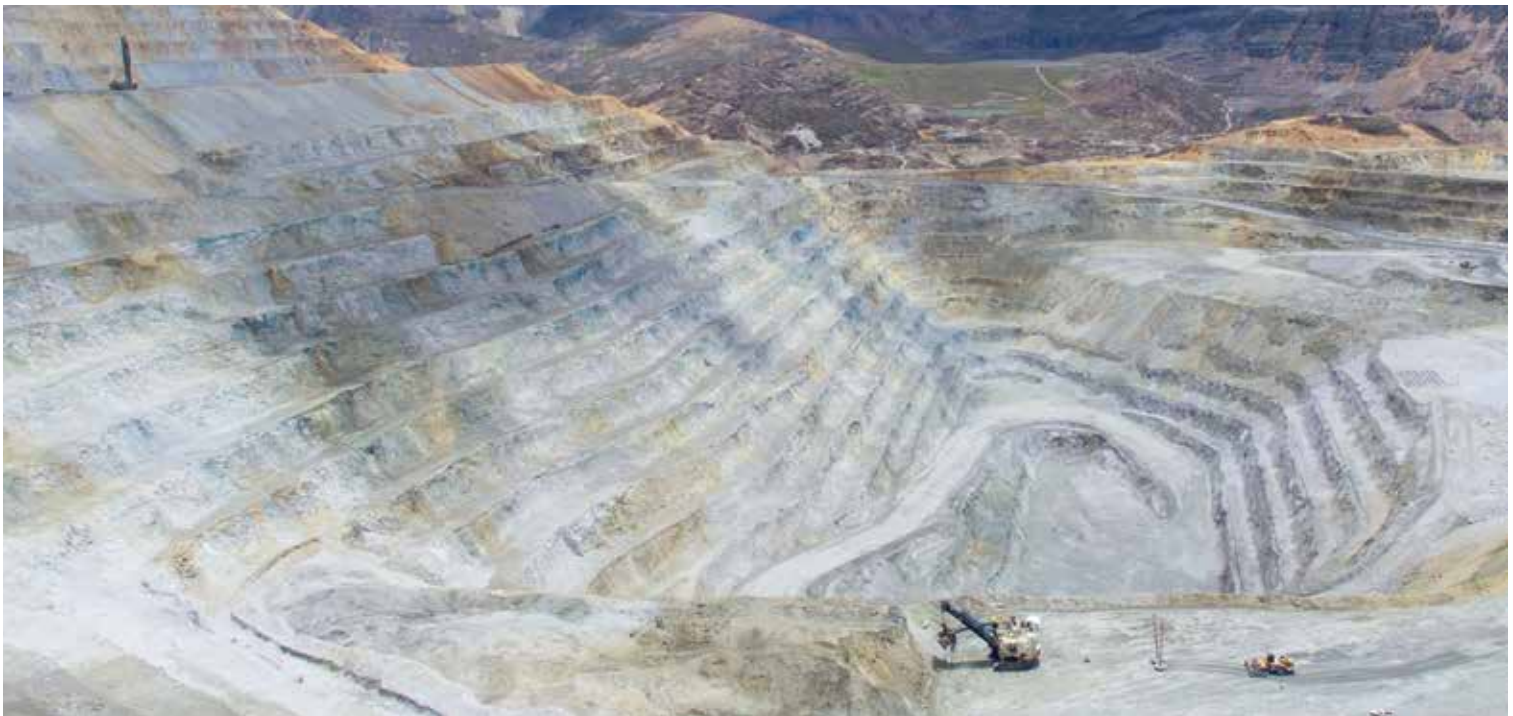
Unidad Minera Toromocho - Mina a tajo abierto 特罗莫克项目-露天矿坑
