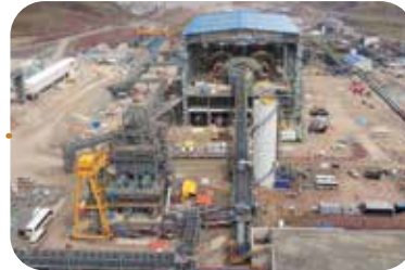
Primer ingreso de mineral al molino SAG 矿石首次进入半自磨机
