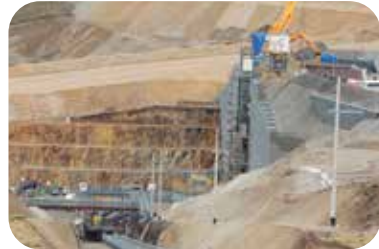
Arranque de la chancadora primaria 初碎站启动
