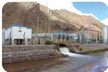
Inicio oficial de operación de la Planta de Tratamiento de Aguas del Túnel Kingsmill 金斯米尔水处理厂正式开始运营
